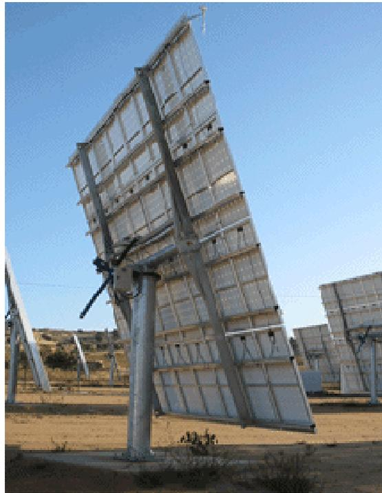
Figura 19: Panel fotovoltaico con un eje. Fuente: [www.adener.com](http://www.adener.com).
