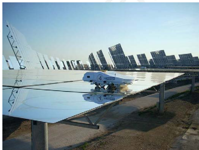
Ilustración 38. Modelo de heliostato de la central termo-solar. Fuente: Google Imágenes
