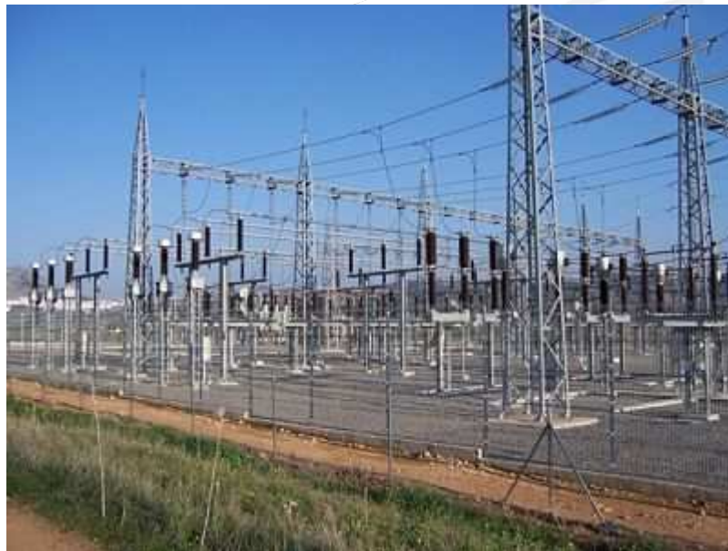
Ilustración 33. Subestación eléctrica. Fuente: Google Imágenes
