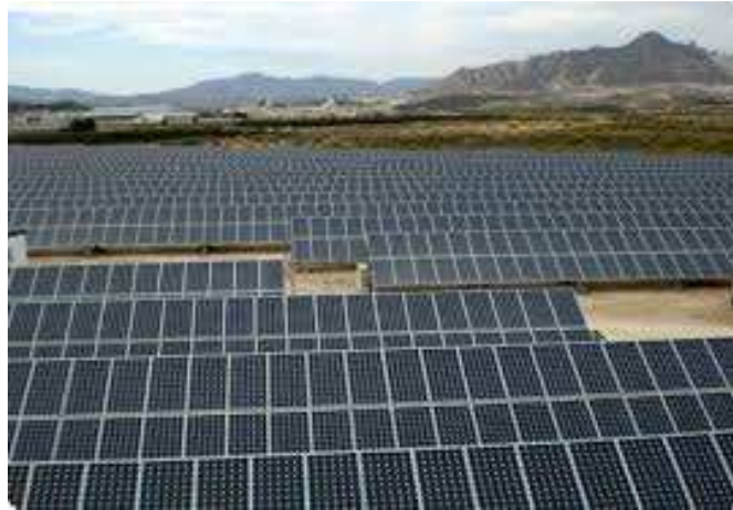
Ilustración 3. Paneles solares. Fuente: Google Imágenes
