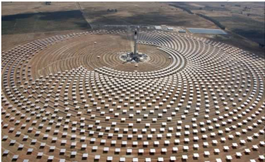
Ilustración 22. Campo de heliostatos o campo solar. Fuente: www.torresolenergy.com
