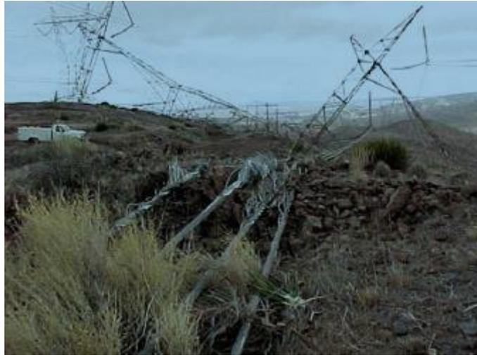
*Ilustración 17. Cascading failure*
