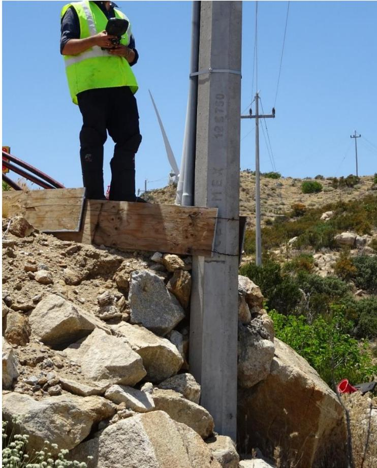
*Ilustración 11. Cimentación inexistente*
