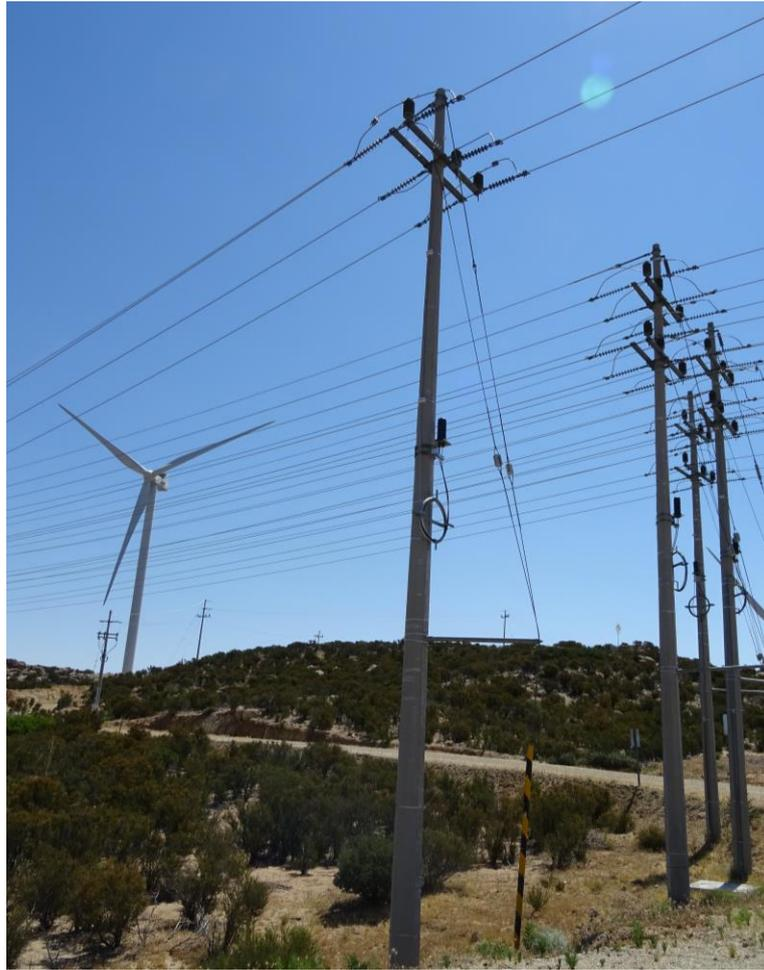
Ilustración 5. Conductores demasiado tensos
