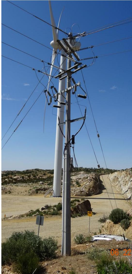
*Ilustración 12. Ejemplo de apoyo antireglamentario*
