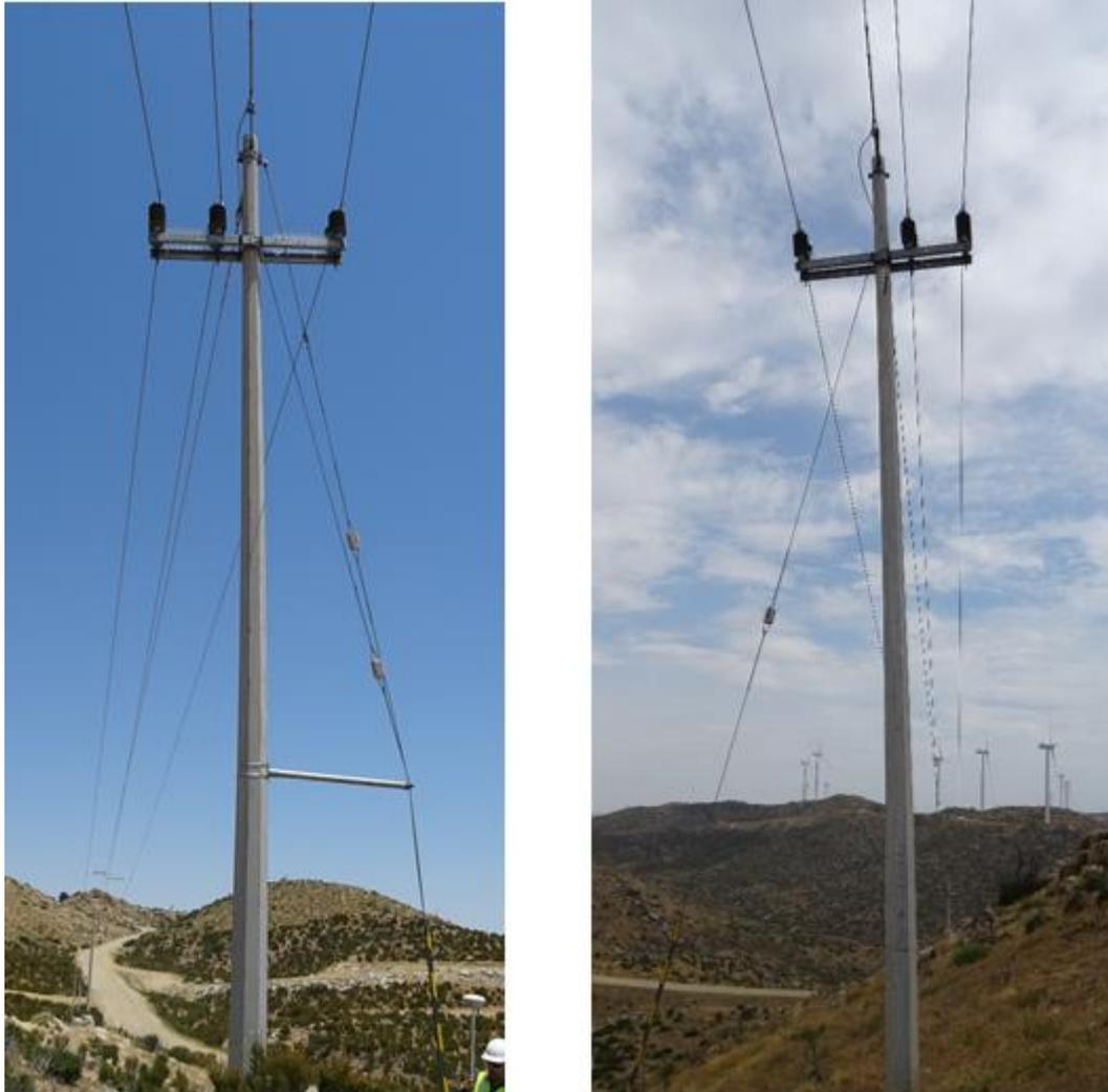
*Ilustración 7. Apoyos en deformación permanente*
