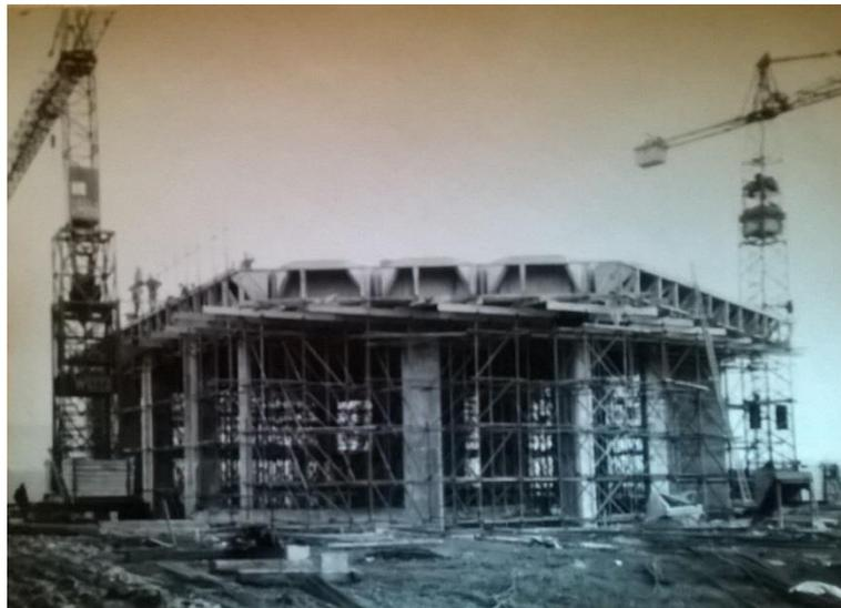
Fig. 13: Instalación de los módulos de hormigón de la techumbre de la iglesia de la Reconciliación. 1961. (ACT)
