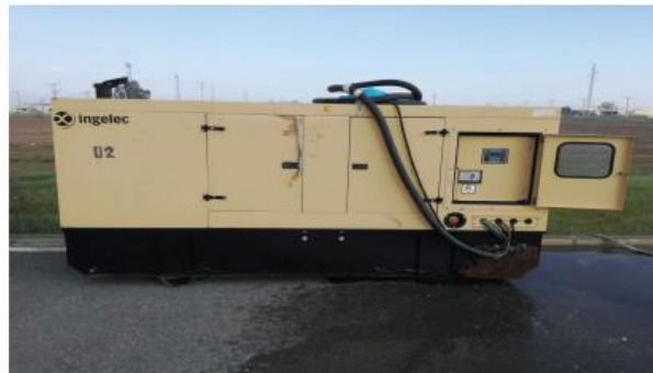
Figura 22. Depósito de combustible y grupo electrógeno de 143 kVA.
