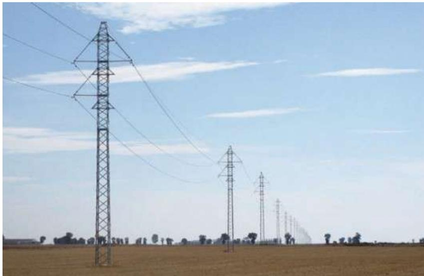
**Figura 2.12.** Línea compacta de 220 kV con crucetas aislantes pivotantes en Valladolid [12]
