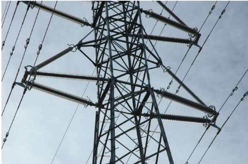
**Figura 2.25.** Cruceta de estabilización con brazo rígido doble
