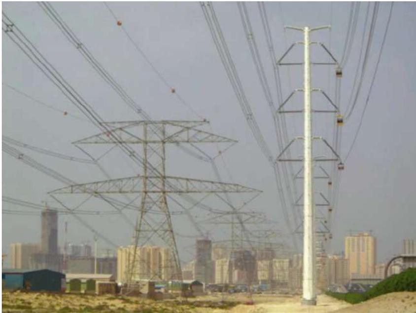
**Figura 2.10.** Línea compacta de 420 kV en Dubai junto a la anterior línea existente [10]
