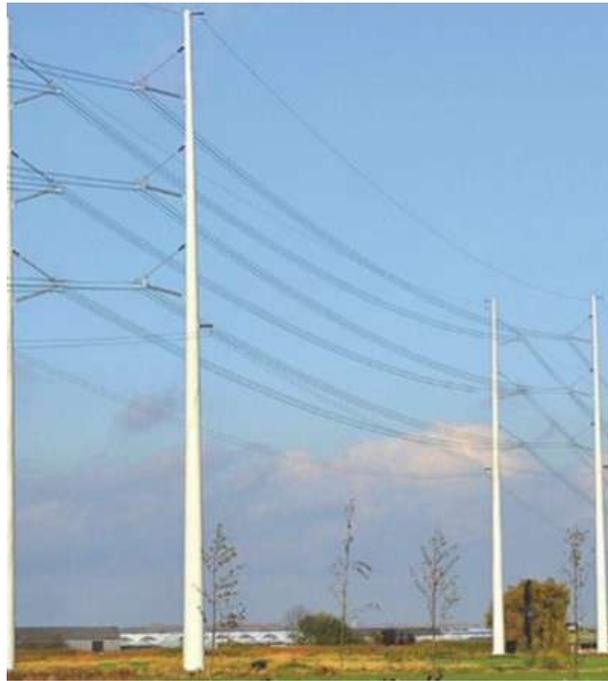
**Figura 2.11.** Línea compacta Windtrack de 420 kV en Países Bajos [12]
