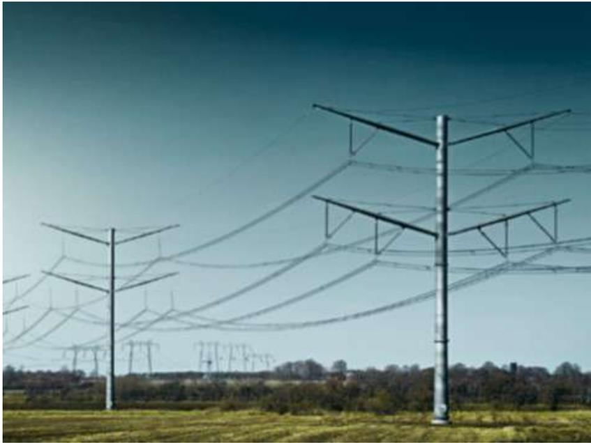
**Figura 2.13.** Diseño experimental en Dinamarca de línea compacta de 420 kV con pilones en V y crucetas aislantes rígidas [12]
