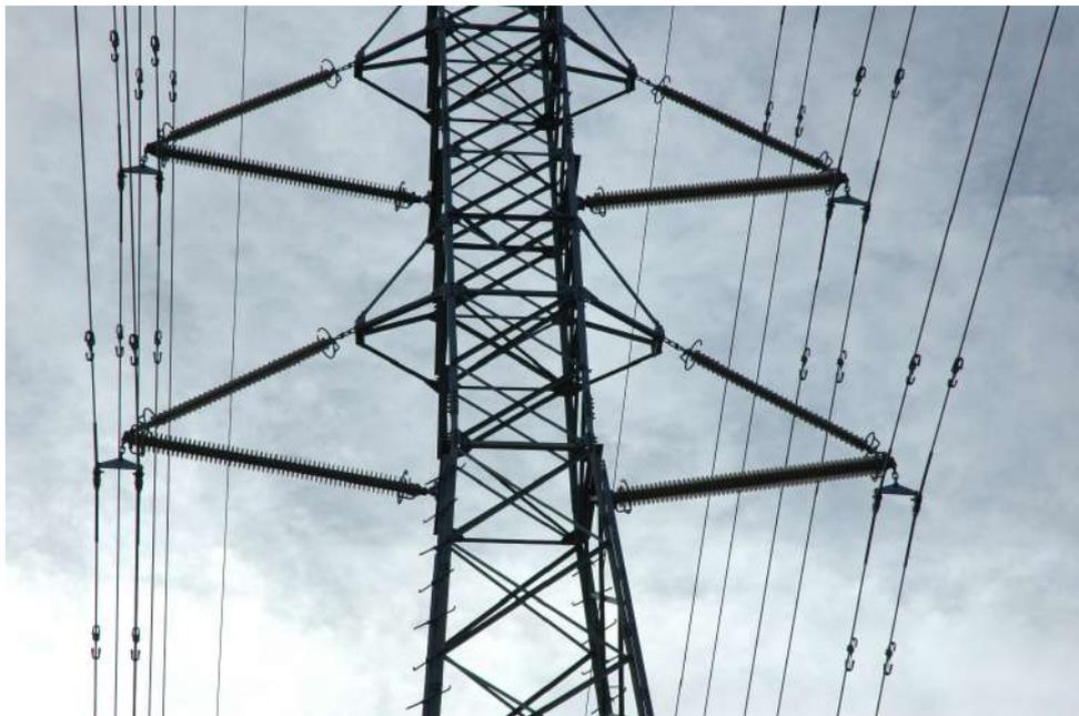
**Figura 1.1.** Línea compacta con crucetas aislantes pivotantes
