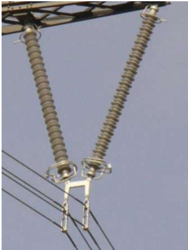
**Figura 2.3.** Soporte con aisladores en V [10]
