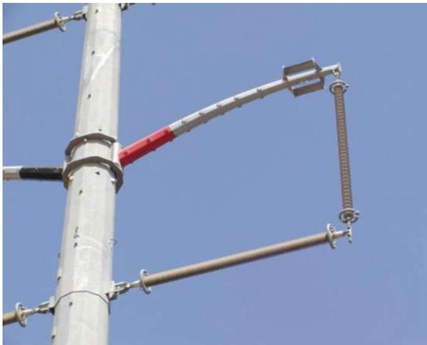
**Figura 2.5.** Brazo aislante suspendido [10]
