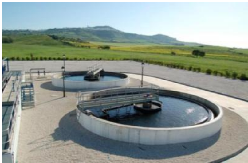
Figura 27: Decantador circular. Fuente [CLED17].
