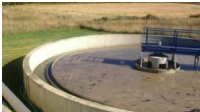
Figura 29: Ejemplo de espesado de fangos por gravedad. Fuente: [CLED17].
