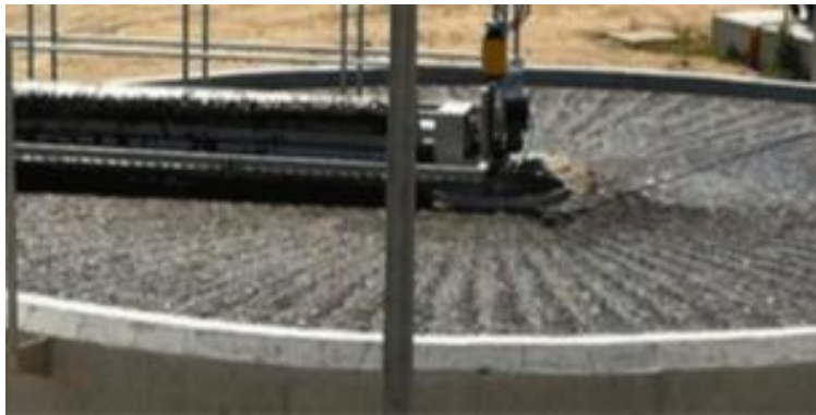
Figura 30: Ejemplo de espesamiento de fangos por flotación. Fuente: [CLED17].
