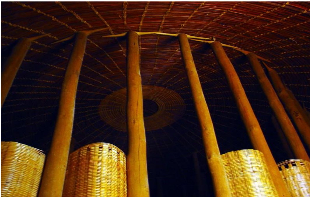
Diferentes pilares que soportan el techo y paneles (equiparados a paredes en las casas modernas) que separan habitaciones (vistos por exterior) (Foto google).
