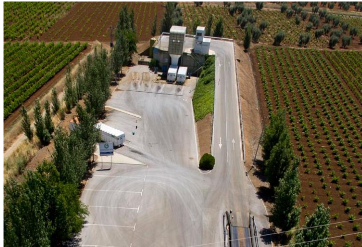
Figura 12. Estación de transferencia de residuos en Almendralejo
