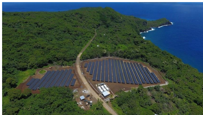
Figura 14. Microrred en la isla de T'au llevada a cabo por Tesla-SolarCity
