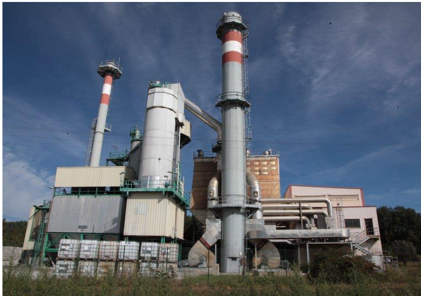
Figura 22. Incineradora de Gerona
