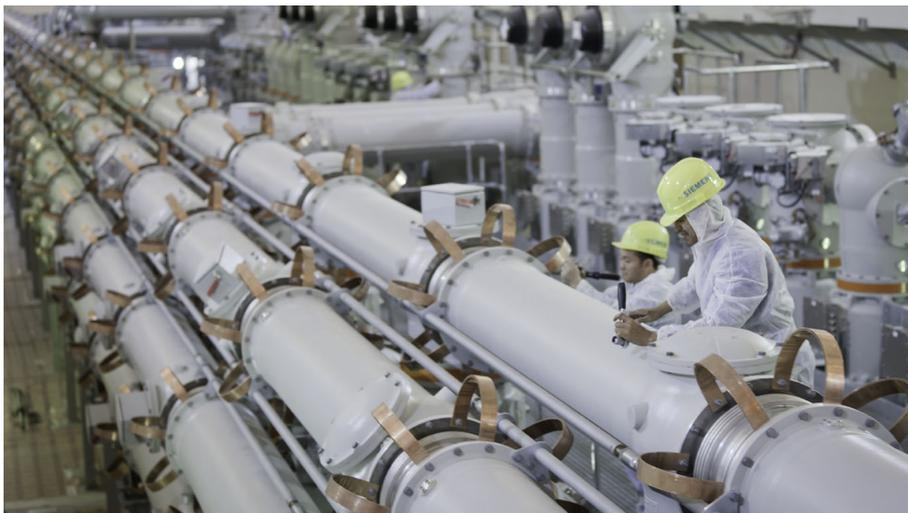
Figura 1.2. Tuberías de un GIS (Fuente:Siemens zona Austral Andina, Primer Proyecto GIS 500 kV de Siemens en la Región).
