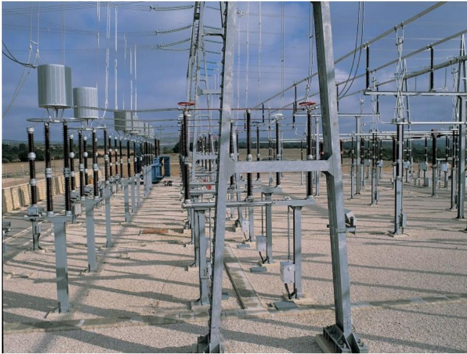
Figura 1.1. Subestación de corte al aire (Fuente:www.ree.es).
