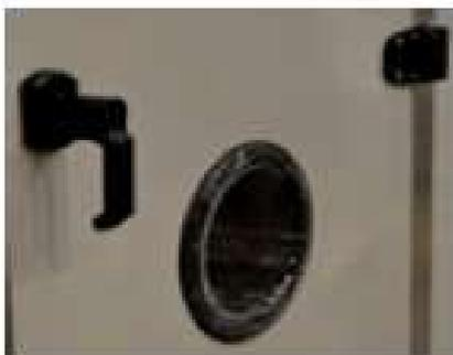
Las puertas de inspección se construyen con los mismos materiales previstos para la realización de los paneles. Están provistas de bisagras, burlete para estanqueidad, mirillas de inspección y cierres de presión progresiva.
