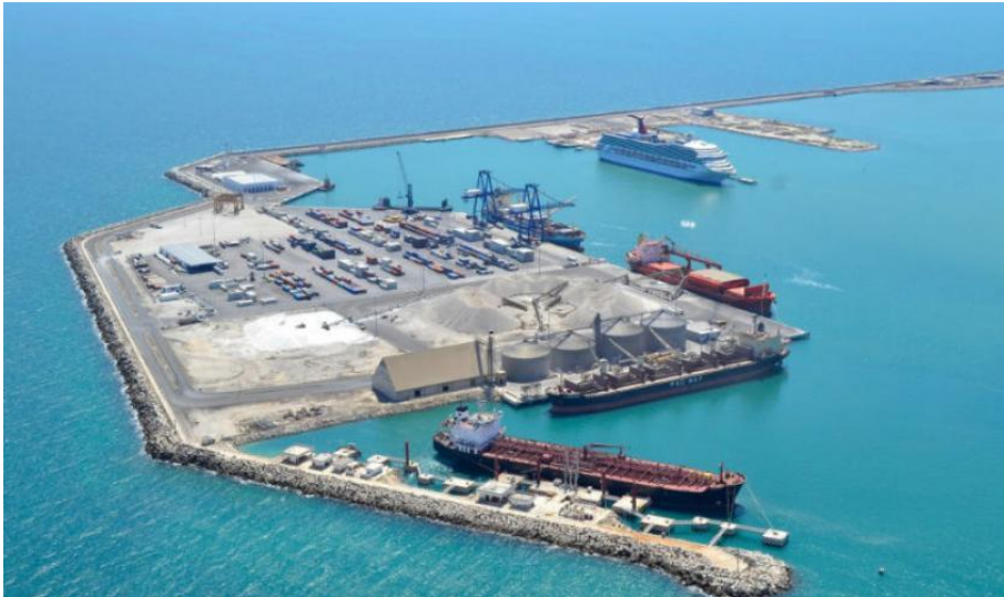
Diques flotantes de Puerto Progreso, Península de Yucatán, México.
