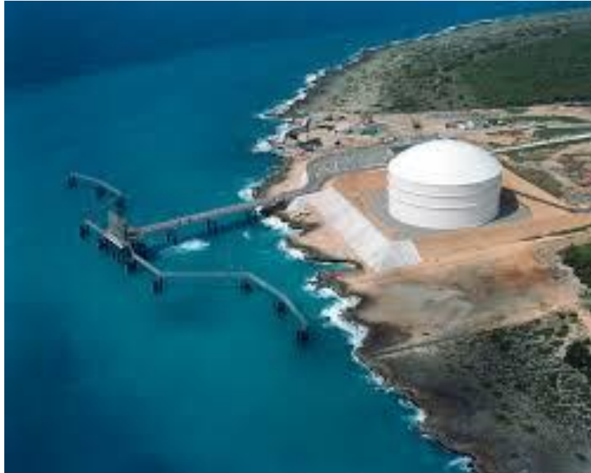
Puerto AES Andrés, ubicado en Andrés Boca Chica en Santo Domingo.
