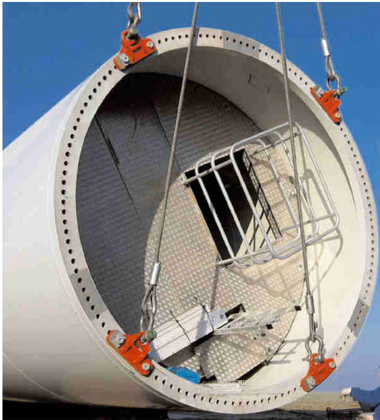
Imagen 20: Ejemplo de puntos de elevación y sujeción de carga
