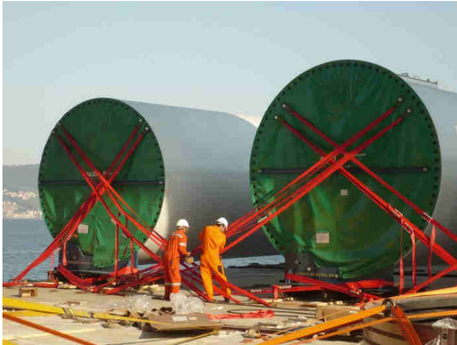
Imagen 19: Sujeción y trincaje de la carga
