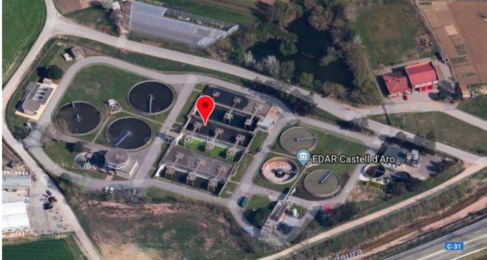
Fig 29. Fotografía de la EDAR Castell d'Aro. Fuente: Consordi Costa Brava.
