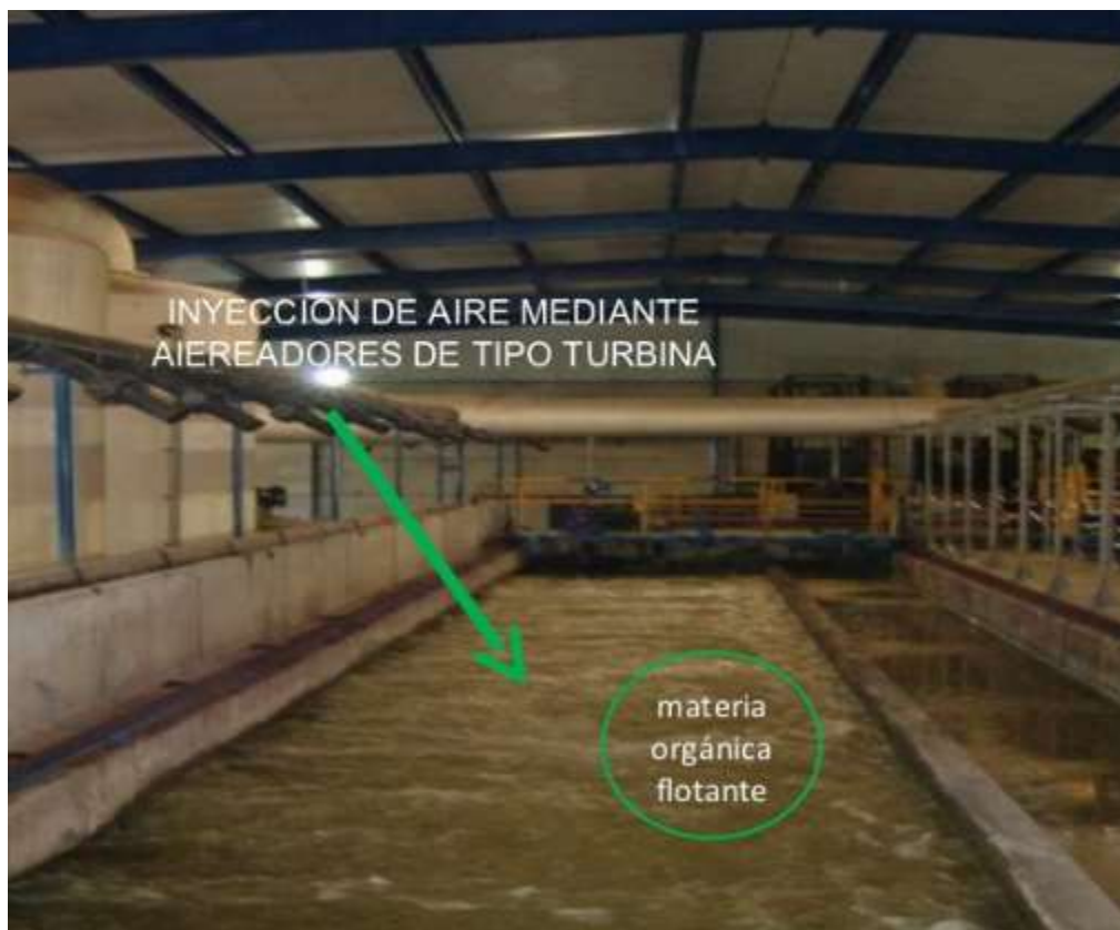
Figura 12: Desarenador de Flujo Inducido.
