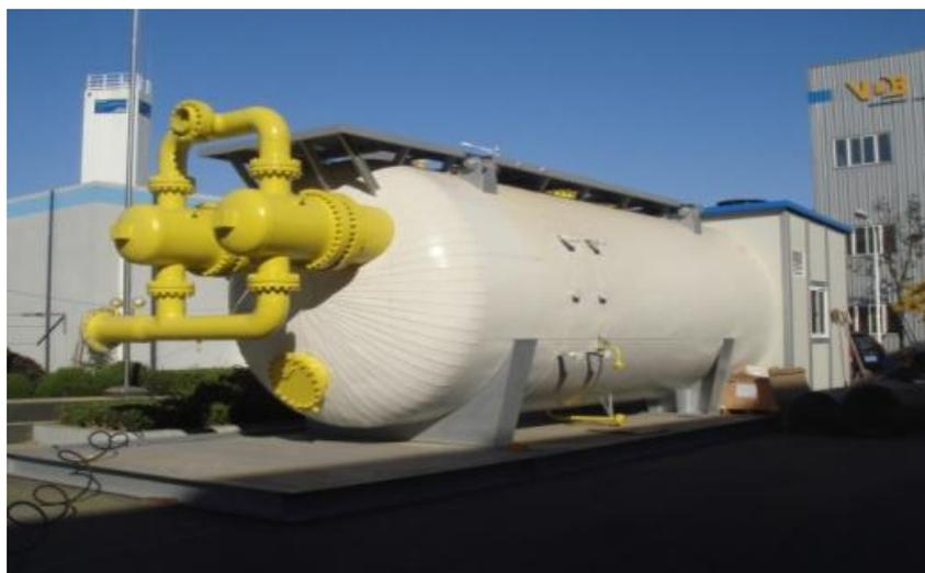
Ilustración 64 Calentador de tipo Water Bath
