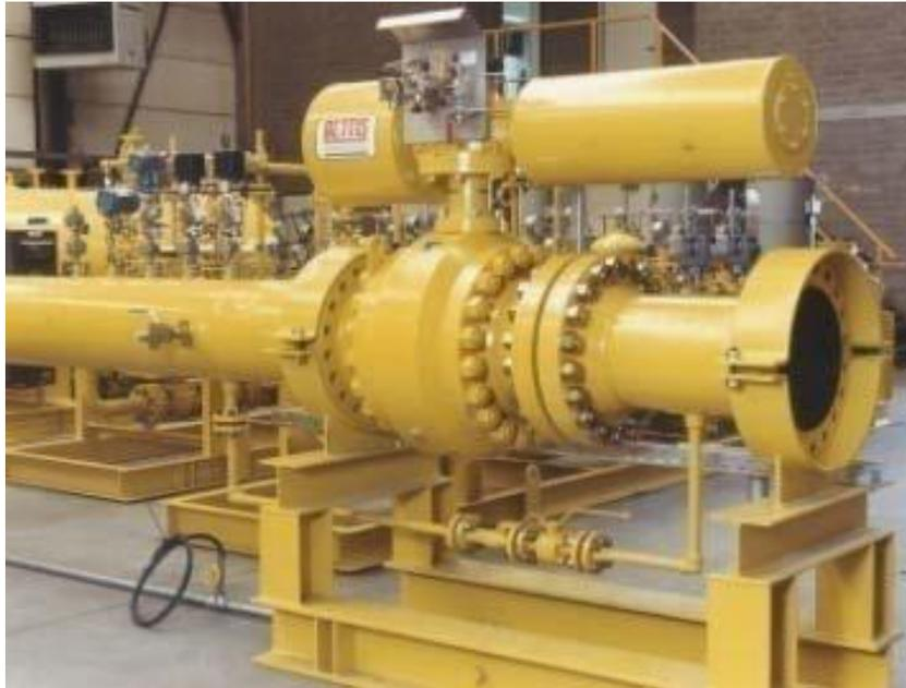
Ilustración 61 Válvula de cierre de seguridad SSV
