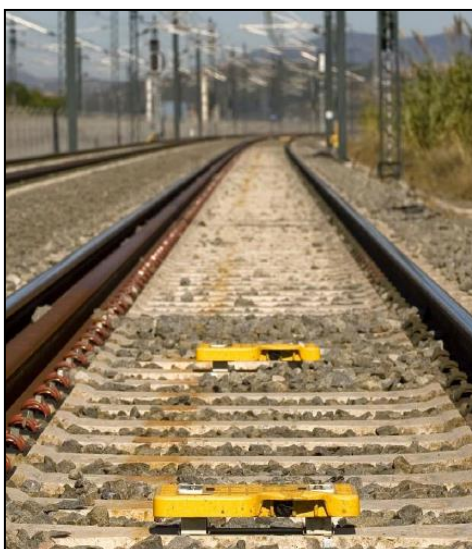
Imagen 8. Instalación de los equipos y sistemas de manera excéntrica entre los ejes de la vía.
