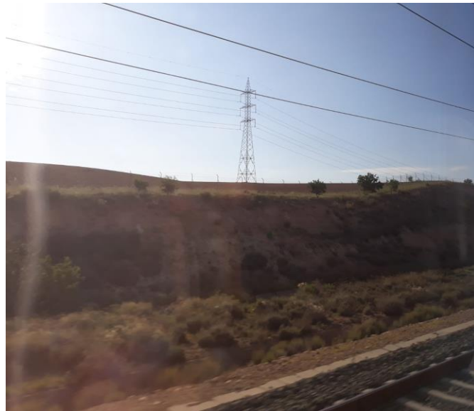
Ilustración 22 Superficie horizontal seguida de desmonte en un tramo de la LAV Madrid-Barcelona concretamente entre Calatayud y Zaragoza
