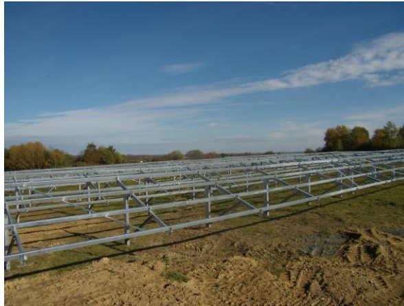
Ilustración 24 Estructura monoposte adecuada para superficie horizontal
