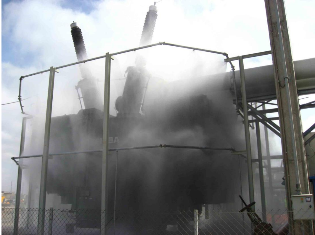
Figura 2-17- prueba del sistema antiincendios
