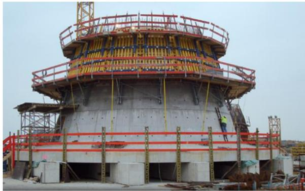
Ilustración 4: Estructura de tipo gravedad [GONZ\_]
