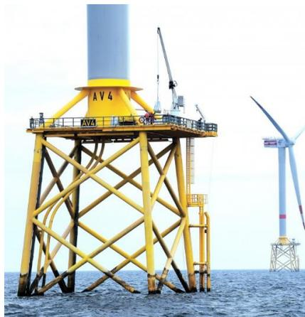
Ilustración 3: Estructura tipo Jacket [FWER\_\_]
