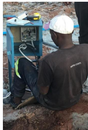
Ilustración 54: Instalación de mandos
