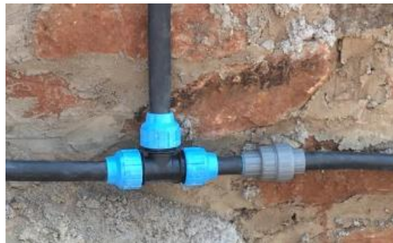
Ilustración 58: Te junto a válvula de no retorno
