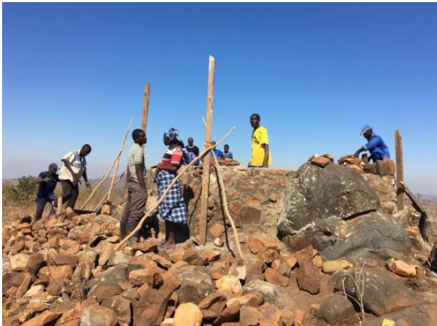
Ilustración 46: Construcción de base
