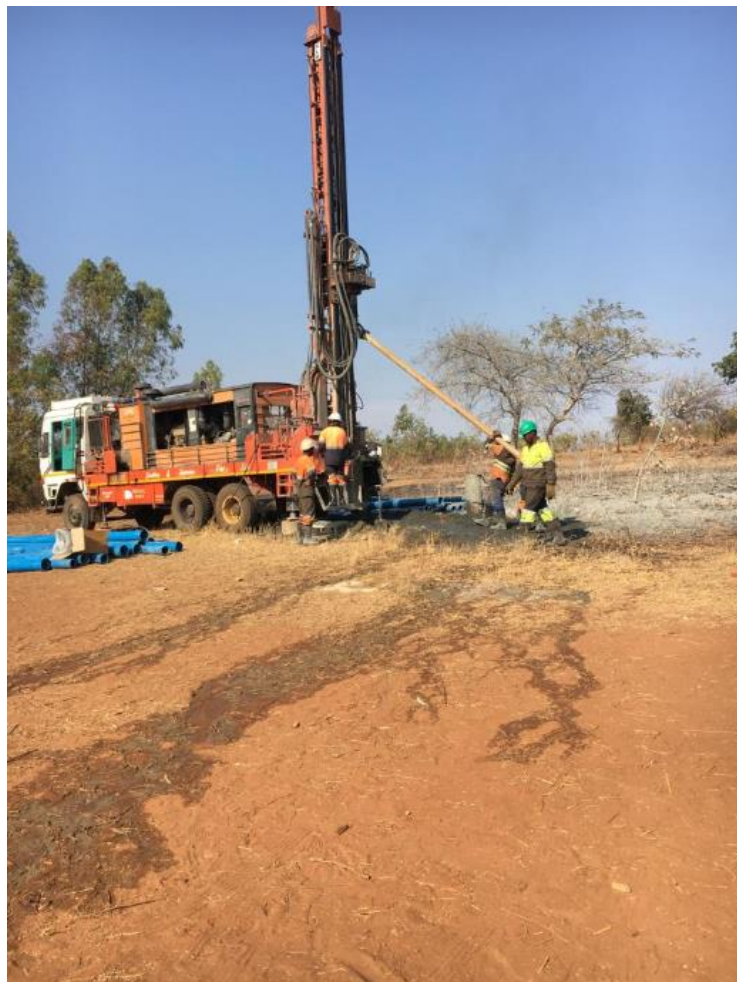
Ilustración 27: Excavación del pozo
