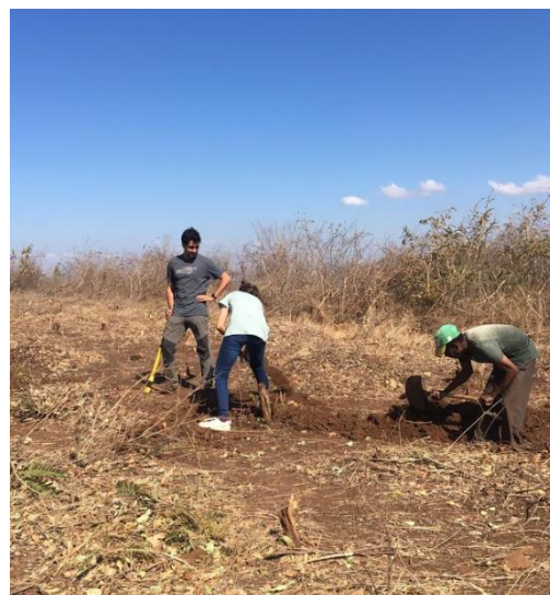
Ilustración 37: Trabajo en las zanjas
