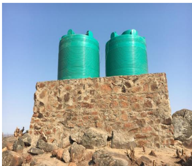
Ilustración 25: Estructura construida de rocas
