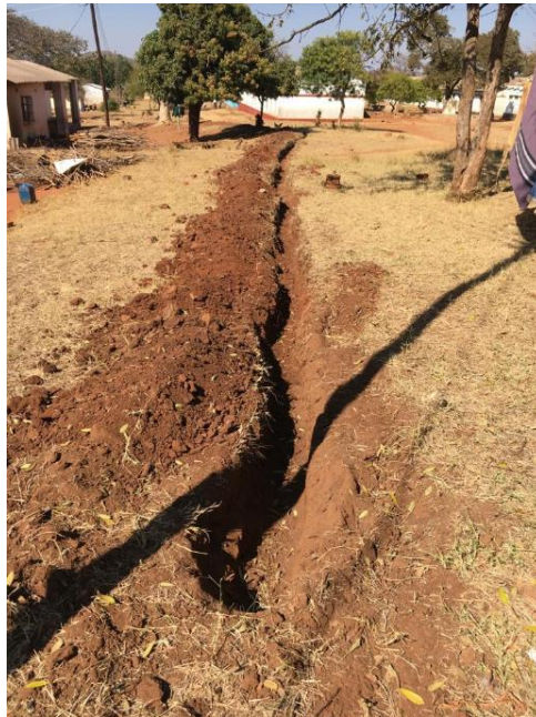
Ilustración 35: Zanja excavada
