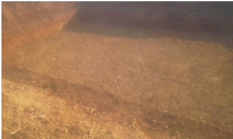
*Ilustración 23. Comienzo del margen despejado en el perímetro para cavar la zanja de la tubería de drenaje. El fondo del estanque ya se encuentra apisonado.*
