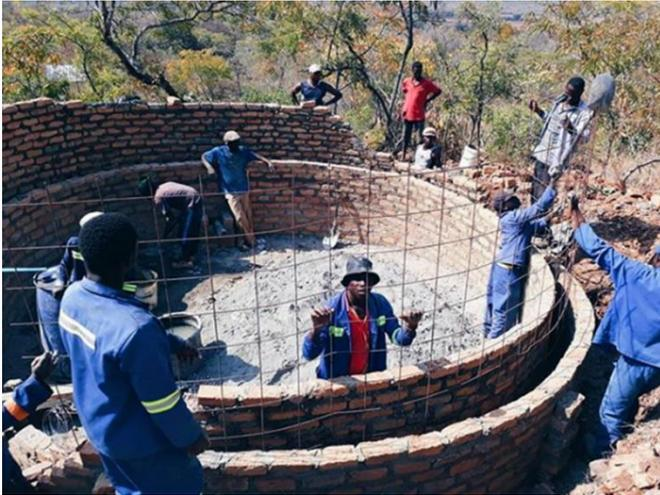
El volumen del decantador sería de  $2,5 \text{ m}^3$  o menor, contando con que necesitaremos bancales de cultivo rellenos de grava de  $5 \text{ m}^3$ , con una superficie de cultivo de  $20 \text{ m}^2$  o menor, dependiendo de los vegetales a plantar. La bomba debería ser capaz de movilizar  $33.000 \text{ l/h}$ , con una potencia de  $304,3 \text{ W}$  y el tanque de bombeo debería ser capaz de contener al menos  $7,25 \text{ m}^3$  de agua.
