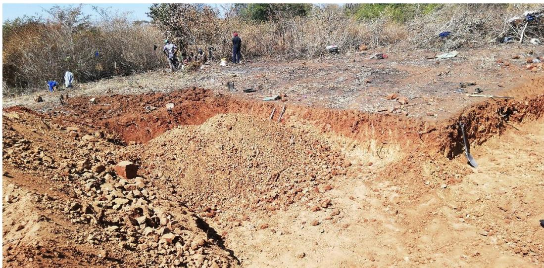
*Ilustración 21. Excavación del terreno al 50% del progreso. Nótese la superficie despejada que marca el perímetro del estanque.*
