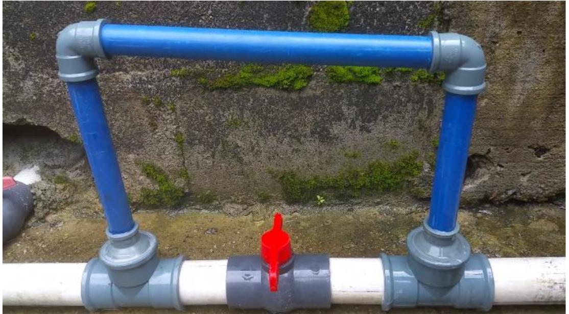
Ilustración 20. Drenaje en T, con opción de mantener el nivel máximo de agua o vaciar el estanque. Fuente: Fish Academy
