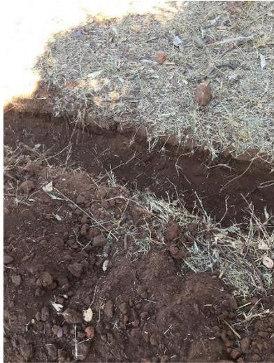
*Ilustración 24. Zanja de 30 cm en el terreno para las conexiones del drenaje con el depósito en los campos de cultivo. El mismo procedimiento será usado para instalar la tubería de alimentación.*
