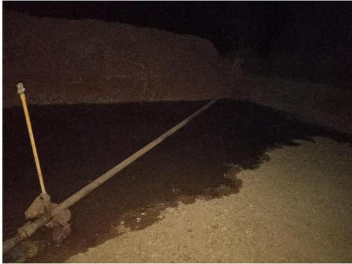
*Ilustración 22. Inundación del fondo del estanque para apisonar el terreno.*
