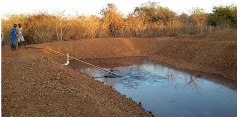
*Ilustración 25. Llenado inicial de la piscina. Obsérvese como la capa de tierra destinada a proteger de rayos UV a la lona se retira conforme se vierte el agua y una parte de la lona se desprende.*
