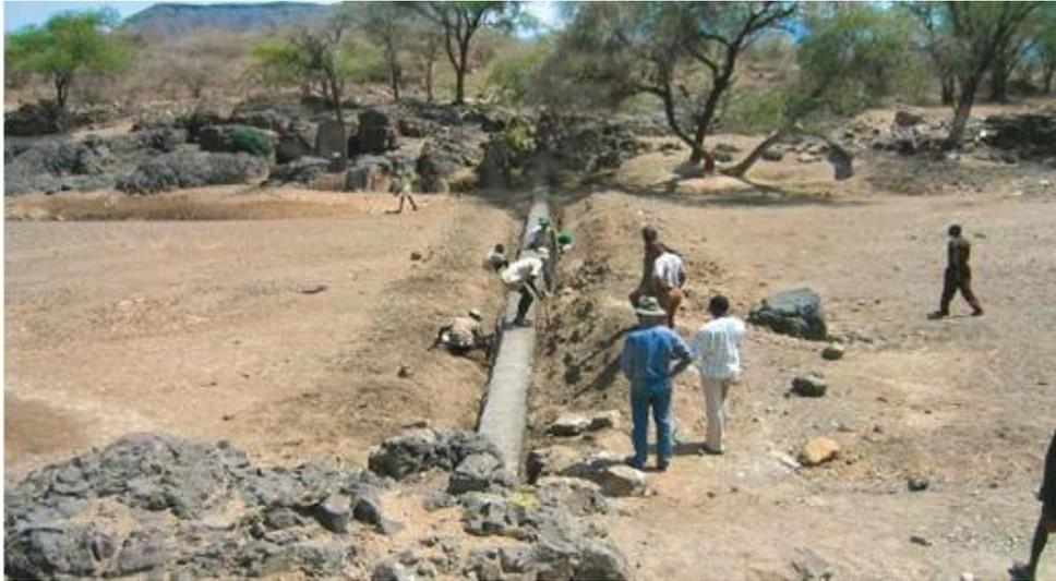
*Ilustración 20. Presa subterránea de hormigón. Fuente: Sam Sam Water*
