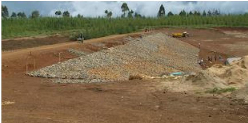
*Ilustración 16. Presa de materiales sueltos. Fuente: Ministerio agua y regadío de Kenia*
