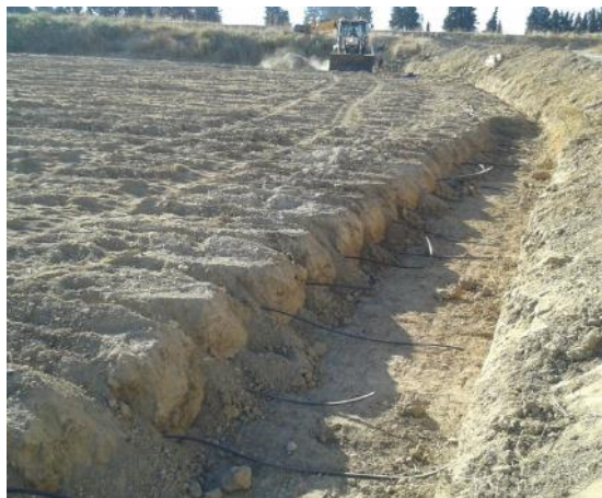
Ilustración 6 Riego subterráneo en cultivo de maíz. Fuente: Azud
