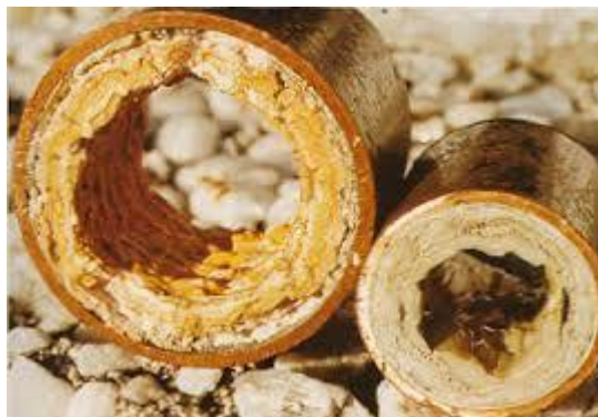
Ilustración 40 Tuberías afectadas por la cal. Fuente: dimasplus.com
