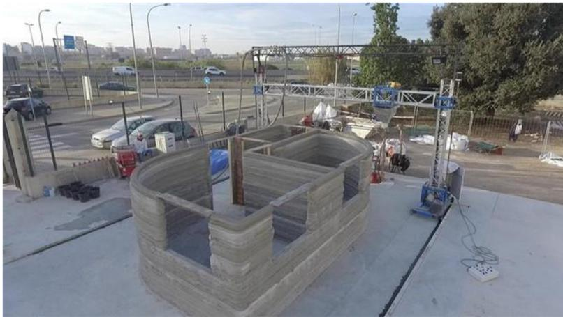
**Figura 2: Vivienda en construcción mediante impresión 3D, extraída de Europa Press, 2018<sup>2</sup>**
