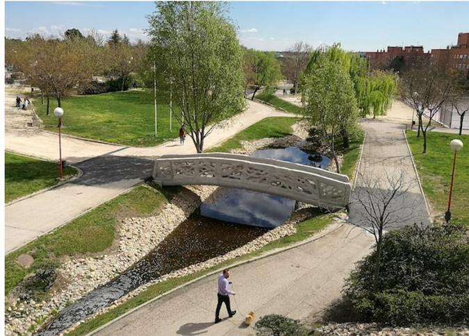
Figura 17: Imagen del primer puente del mundo impreso con concreto en 3D, Alcobendas (Madrid, 2016)<sup>23</sup>
