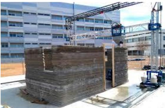
Imagen de la vivienda construida con impresora 3D por BeMore finalizada:
