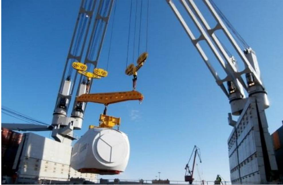
Imagen 19: Carga de un *nacelle*
