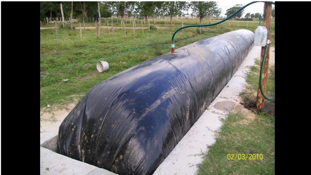
*Figura 4.12. Modelo Horizontal del biodigestor*
