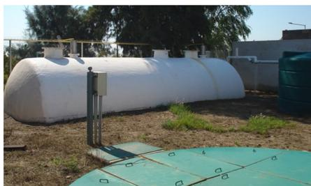
*Figura 1.14. Biodigestor de flujo continuo*
