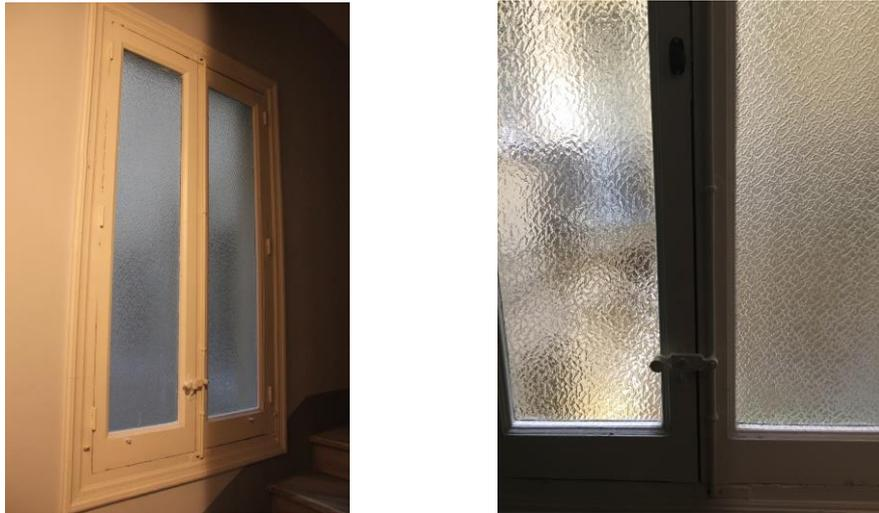
*Figura 10. Ventanas de carpintería de madera con cristal simple martillado.*
