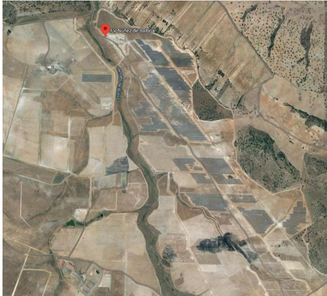
Figura 4-3: Planta fotovoltaica Núñez de Balboa.
