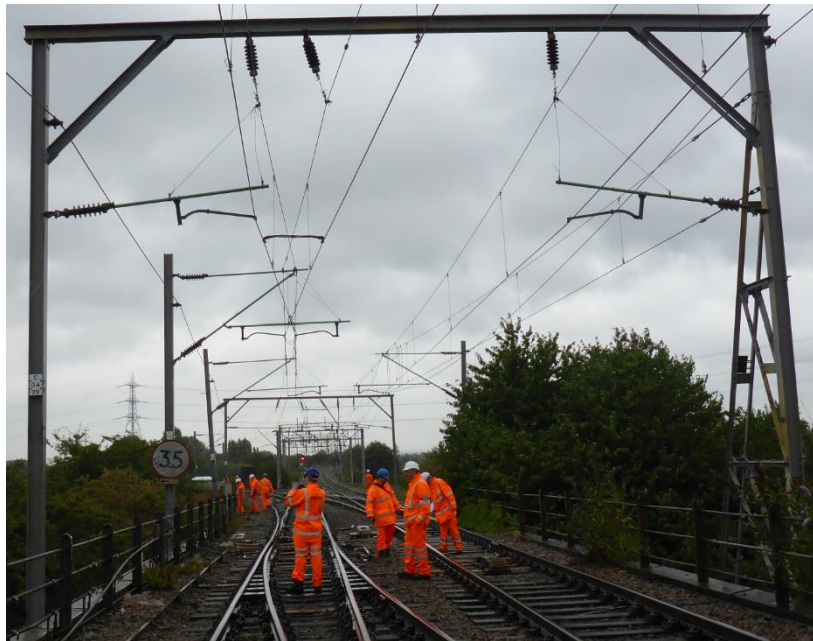
Figura 38: Estructura C/04/29 con tensor en lado derecho
