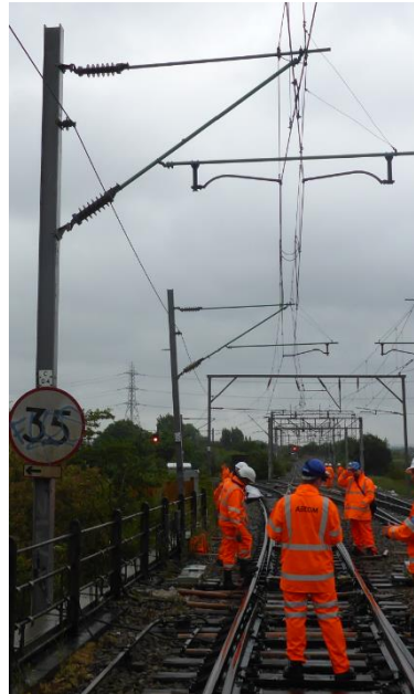
Figura 39: Poste de la estructura C/04/30
