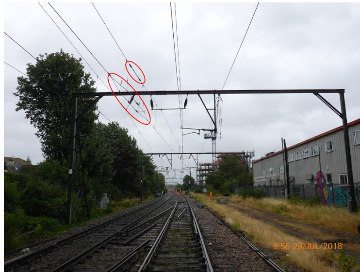
Figura 30: pórtico C/04/22. Aislador de sección señalado en rojo
