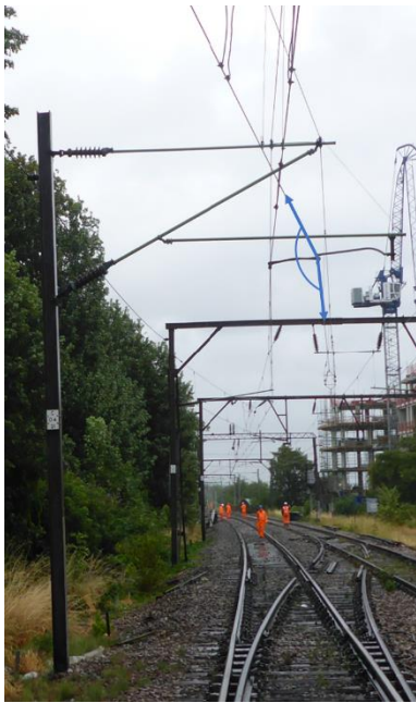
Figura 28: Ángulo del atirantado del cable B
