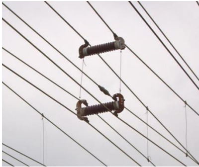
Figura 13: Knuckle aislador
