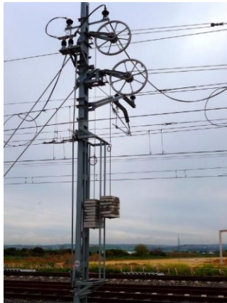
Figura 9: Cantón con compensación independiente y automática
