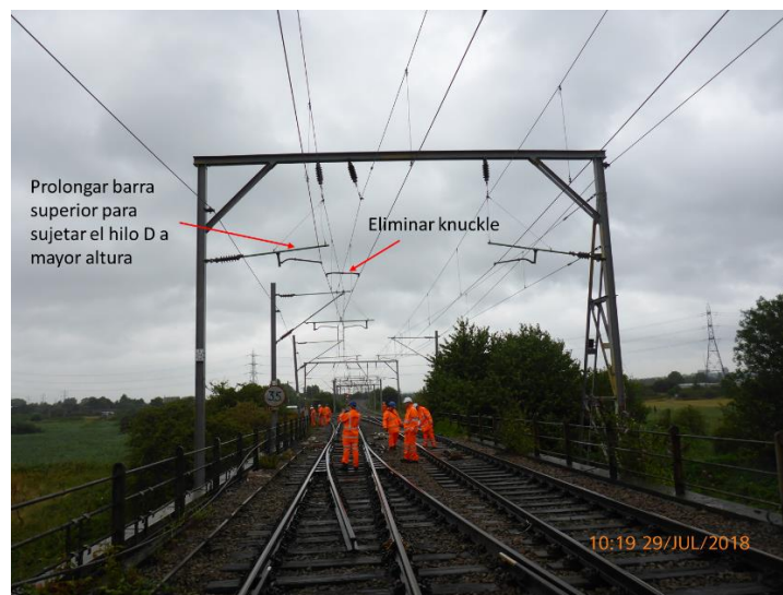
Figura 49: Modificaciones a realizar en la estructura C/04/29
