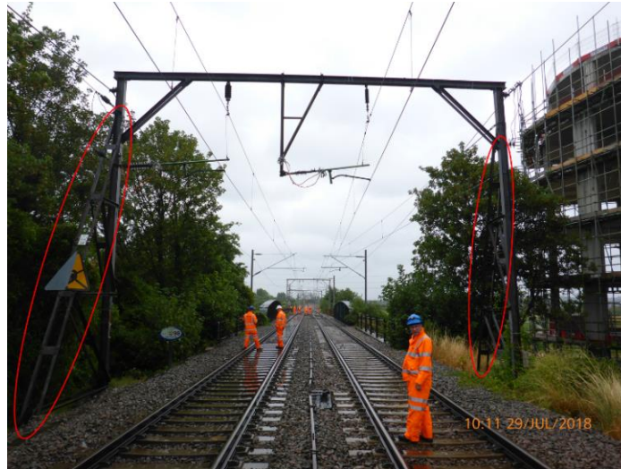
Figura 34: Pórtico C/04/25 con tensores para soportar anclajes
