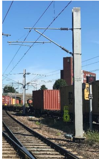
Figura 40: Poste con posibilidad de anclaje sin tensor
