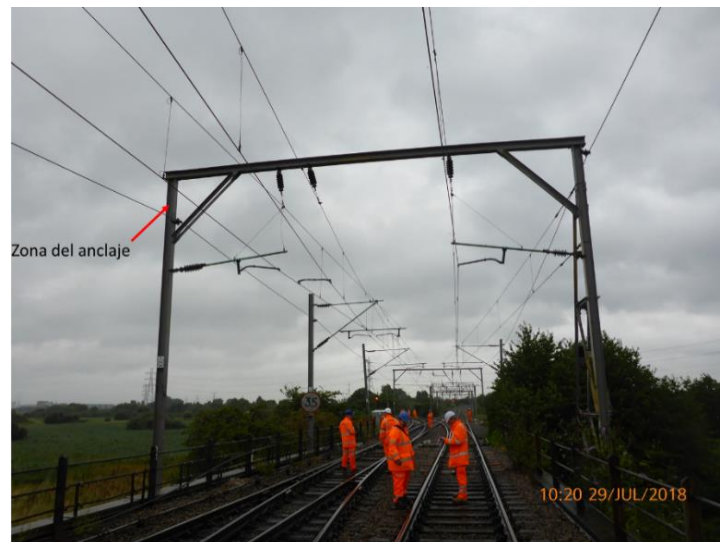
Figura 35: Estructura del anclaje para la opción 1
