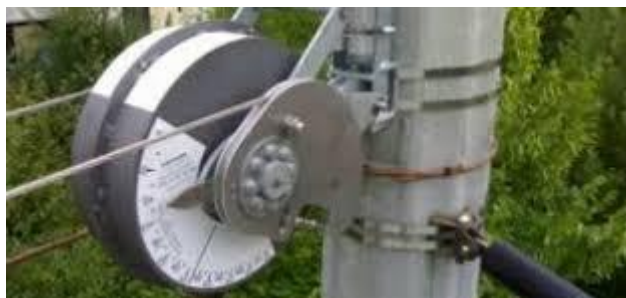
Figura 10: Muelle torsional en sistema de compensación
