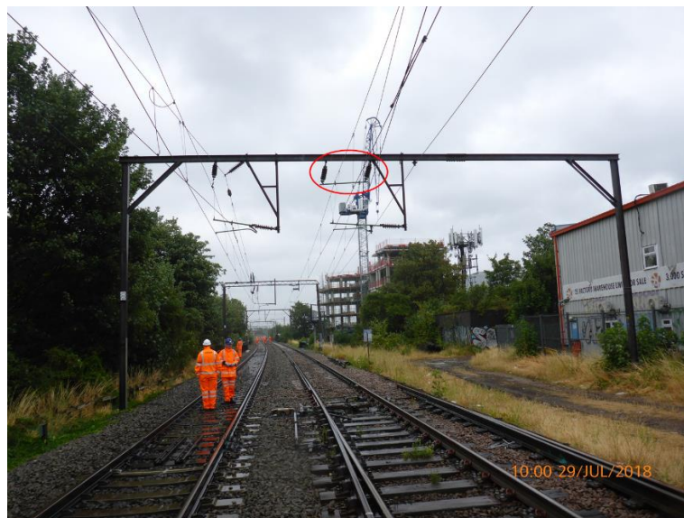
Figura 31: Pórtico C/04/23, marcado en rojo el aislador doble
