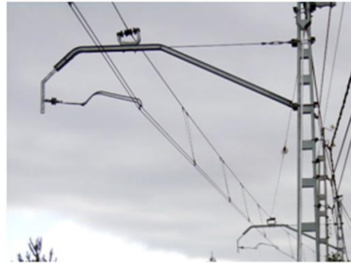
Figura 7: Ménsula de celosía
