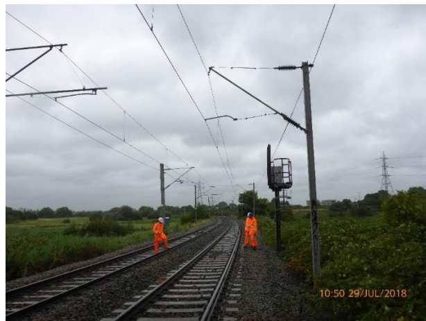
Figura 3: Ejemplo de catenaria flexible
