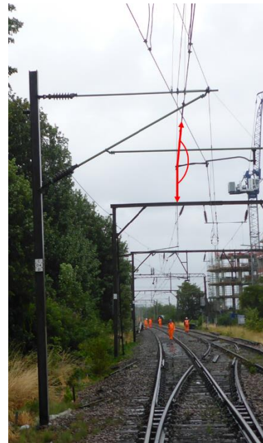
Figura 29: Ángulo del atirantado del cable A
