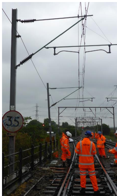
Figura 18: Ménsula doble sin momento torsor
