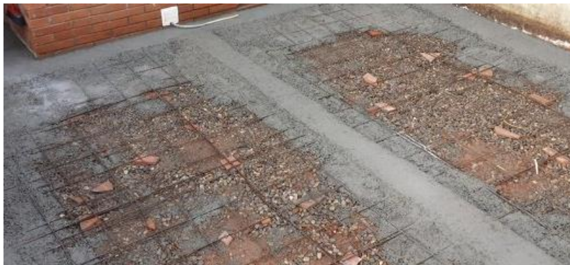
Figura 8: Ejemplo solera con hormigón armado
