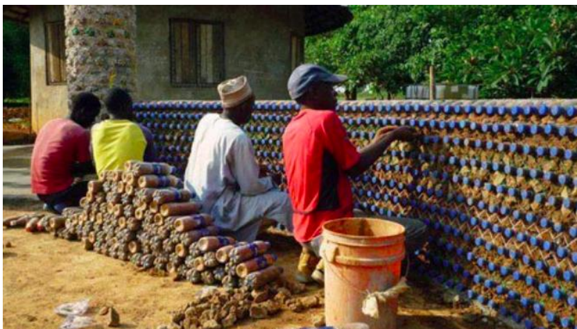
Figura 3: Método de construcción con botellas de plástico
