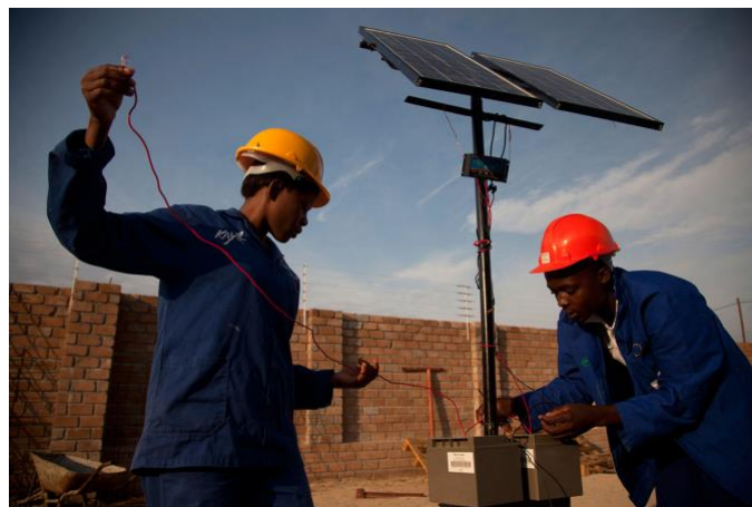
Figura 13: Solución lumínica. Sistema de placas solares con baterías incorporadas
