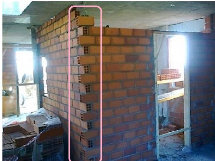
Figura 10: Detalle constructivo muro. Enjarjado de ladrillos esquina
