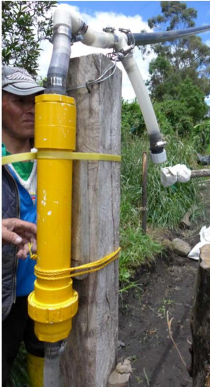
*Figura 9: Filtro de ácido sulfhídrico (H<sub>2</sub>S) [diseño]*
