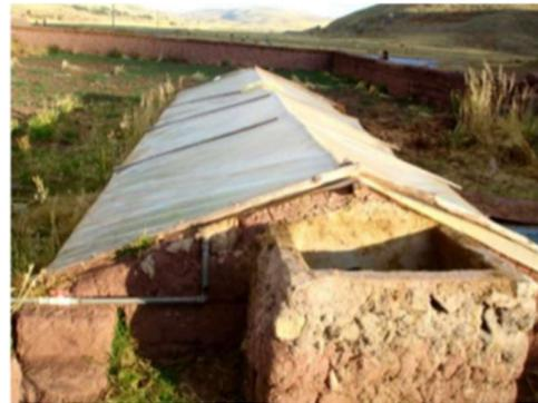
*Figura 16: Ejemplos reales de biodigestores tubulares [19]*
