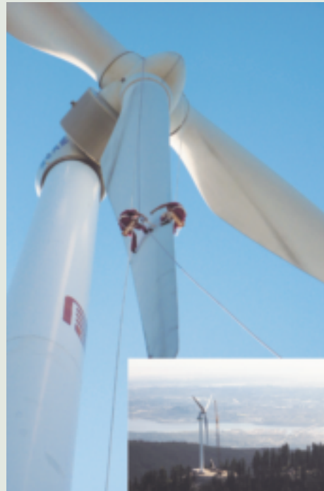
Figura 1. Dificultades de accesibilidad a los aerogeneradores
