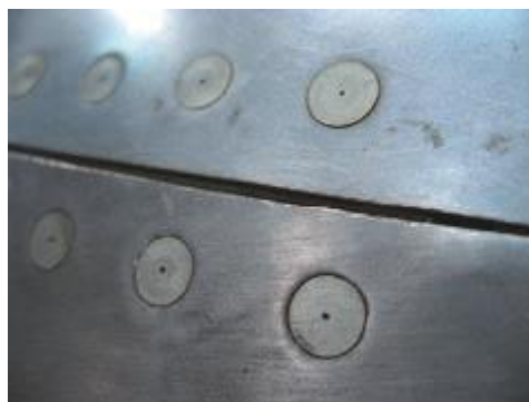
Ilustración 19: Ejemplo de remaches [Casiopea, 2012]
