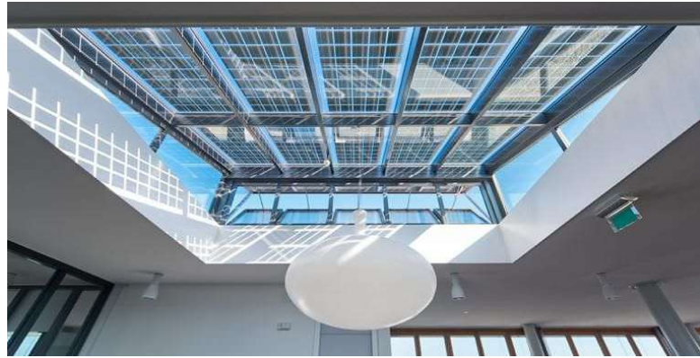
Ilustración 33 Tecnología Double Glass
