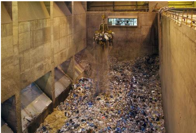
Figura 39. Silo de almacenamiento de residuos (Foso Zabalgardi, n.d.)
