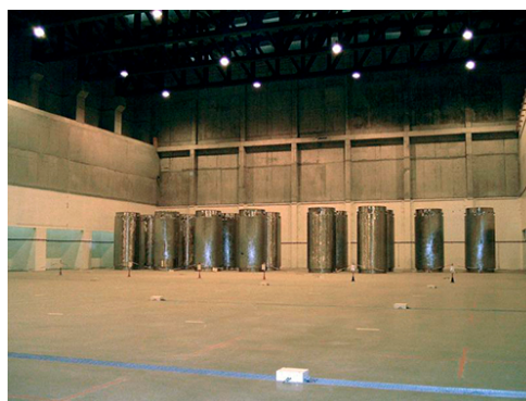
Figura 2-20: ATI Tipo edificio (Trillo)
