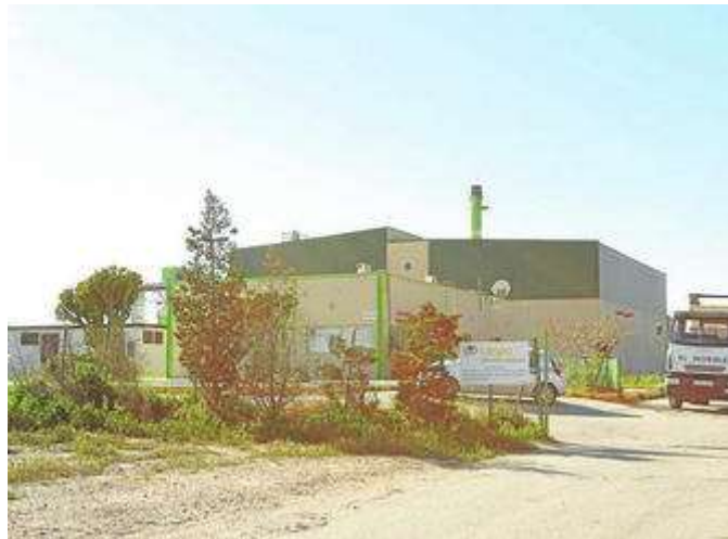
Ilustración 4: Planta de recuperación energética de residuos agrícolas en Níjar, Almería [4]
