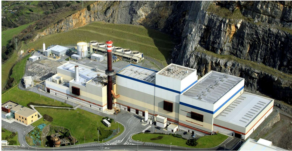
Ilustración 3: Planta de recuperación de RSU en Bilbao [3]
