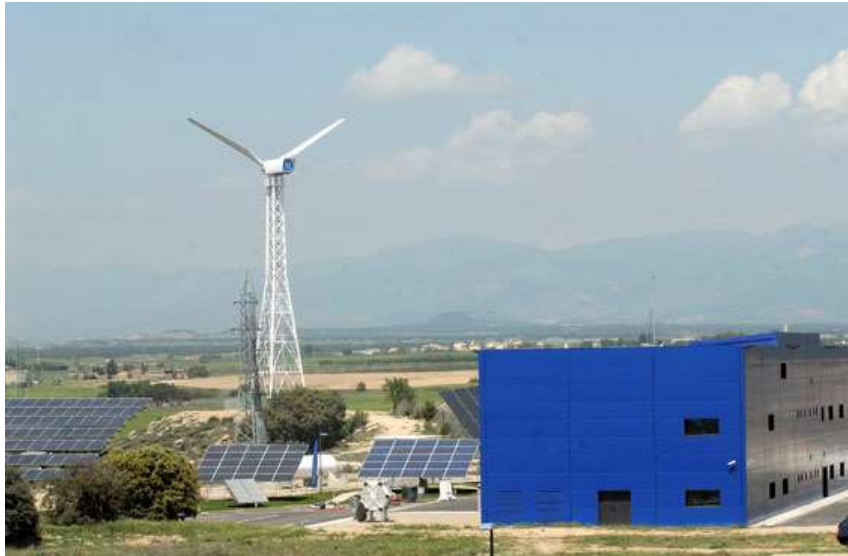
Ilustración 8: Instalaciones del proyecto IHER, Huesca [8]
