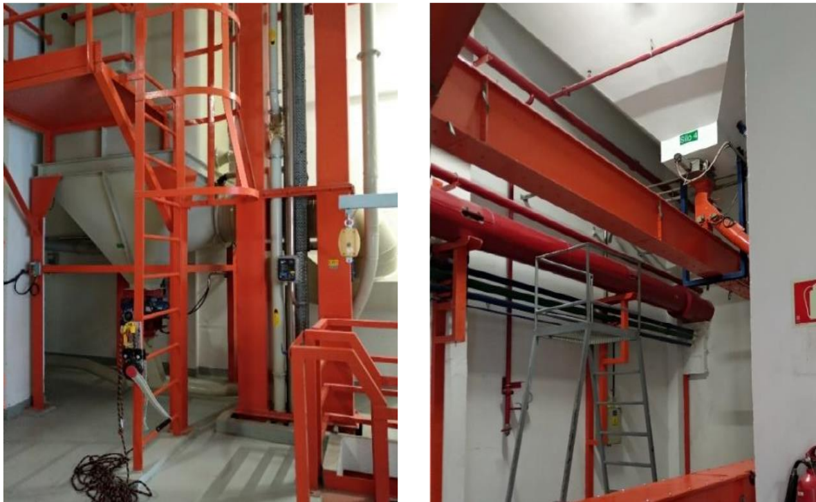
Figura 11. Silos de materias primas
