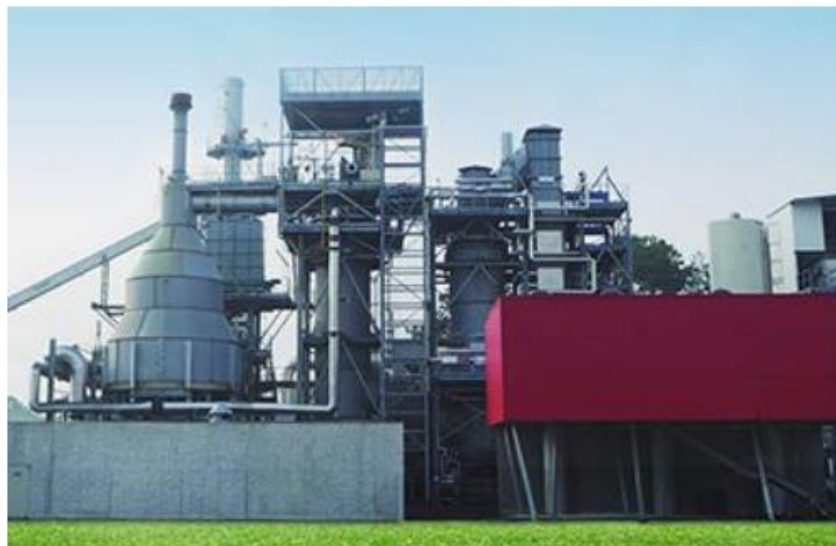
Figura 6. Planta de gasificación Morcenx
