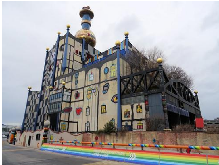
Figura 18. Planta de incineración Spittelau (Viena)
