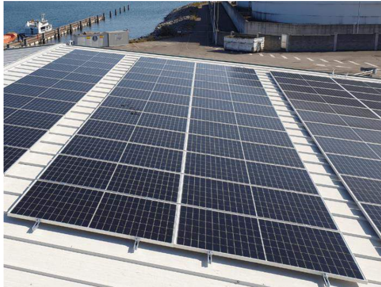
Ilustración 12: Estructura fija coplanar sobre cubierta. Fuente: Alusin Solar
