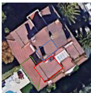
Ilustración 22: Cubiertas vivienda. Fuente: Elaboración propia
