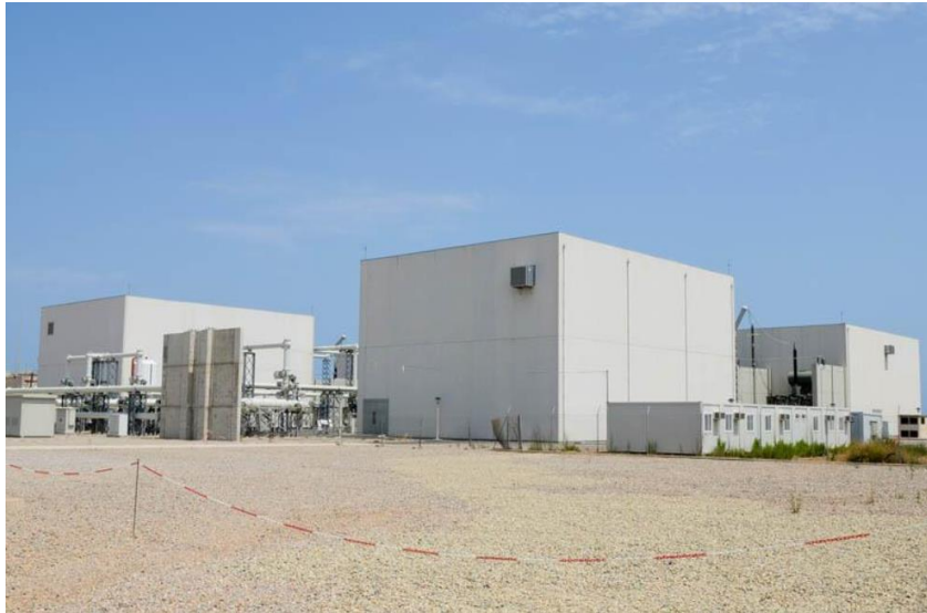
Ilustración 65 – Estación de conversión de Morvedre – [19]
