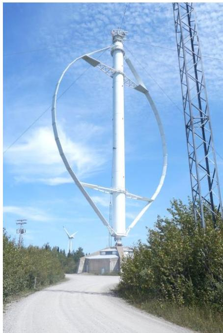
Ilustración 9: Aerogenerador de eje vertical. Fuente: wikipedia.
