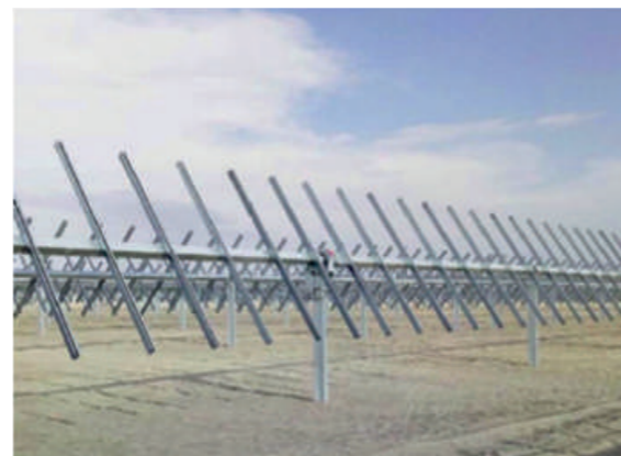
DETALLE DE SEGUIDOR SOLAR SOLTEC
