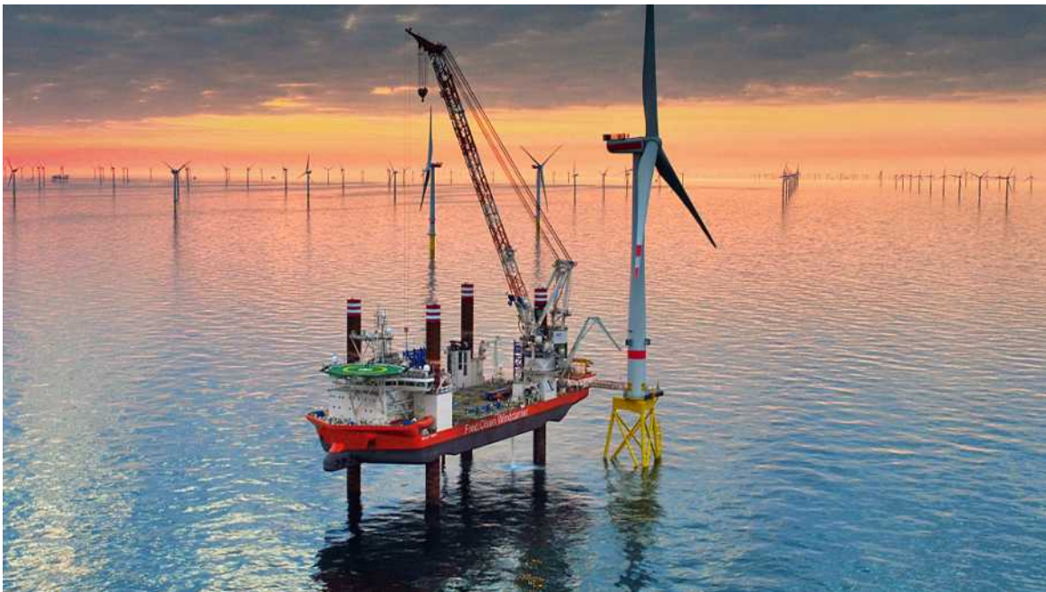
Figura 39. . Instalación turbina eólica marina
