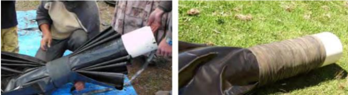
Figura 24: Resultados de los tubos de entrada y salida del biodigestor en proyectos de Manos Unidas (Fuente: Proporcionado por MMUU)
