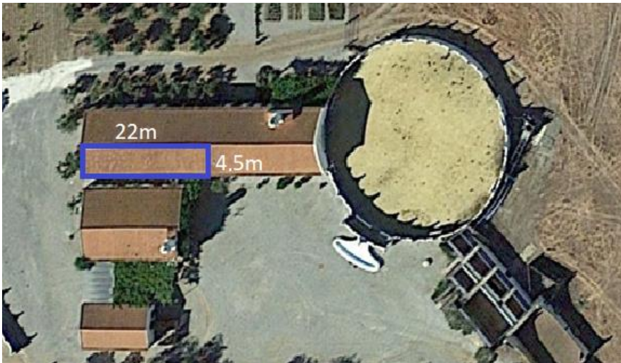
Ilustración 9: Localización paneles fotovoltaicos
