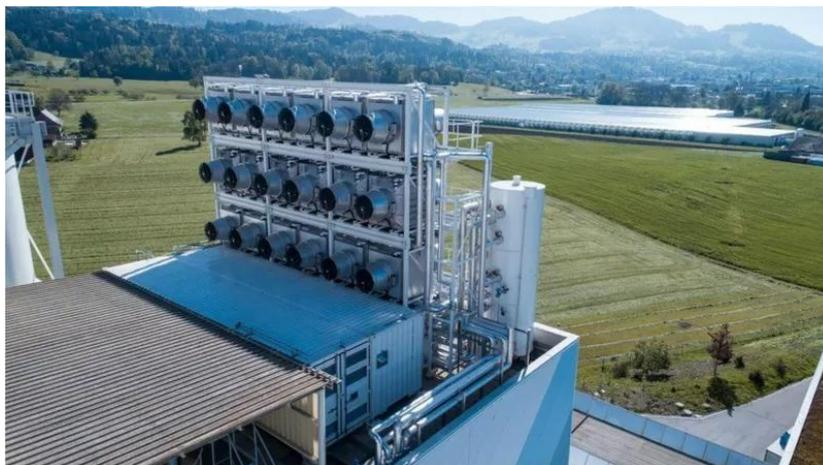
*Ilustración 38. Extracción de CO<sub>2</sub> con fines comerciales en Suiza. Fuente: BBC, Climeworks*
